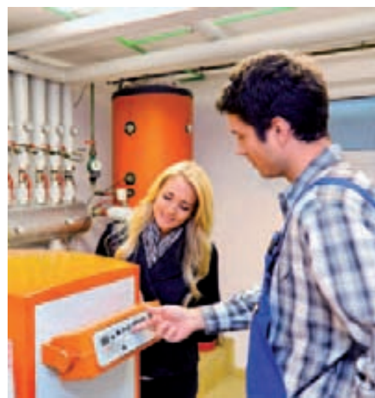
Die Überprüfung oder der Austausch des Heizkessels ergänzt die Sanierungsmaßnahme.
