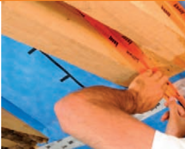
Knauf Insulation Luftdicht-Dämmsystem LDS: Montage von innen.
