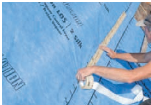
Die Herstellung einer dauerhaft dichten Gebäudehülle gehört zu den wesentlichen Forderungen der DIN 4108-7.
