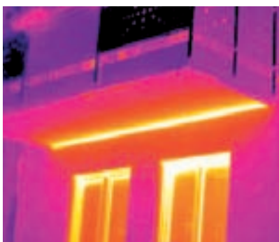
Die Infrarotaufnahme identifiziert Bereiche mit erhöhtem Wärmefluss. Dieser führt zu höheren, äußeren Oberflächentemperaturen.
