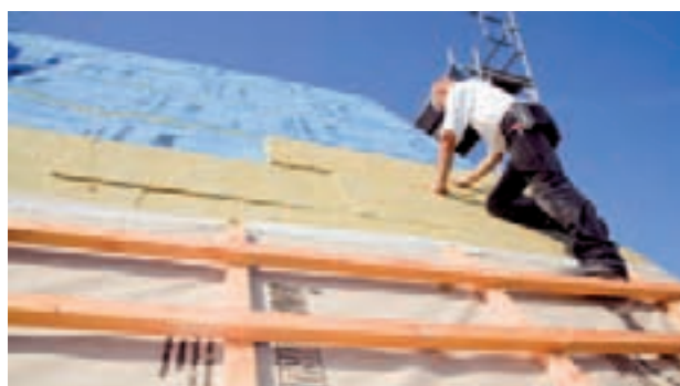
Die EnEV fordert nachträglich Dämm-Maßnahmen im Gebäudebestand.
