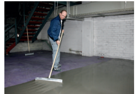
Mit PCI Zemtec ® 180 läßt sich ein schnell belastbarer Bodenausgleich einfach herstellen
