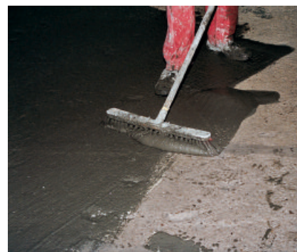
PCI Repahaft wird auf den Untergrund aufgebürstet. Der Estrichmörtel wird sofort danach auf die frische Haftbrücke aufgetragen.
