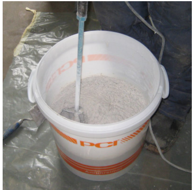
Mit einem leistungsfähigem Rührgerät ca. 1 Minute mischen, bis eine homogene, knollenfreie Masse entsteht.
