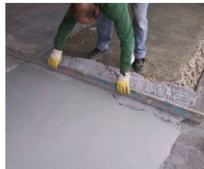
Mechanisch belastbare Flächen können ohne Grundierung mit PCI Repafast APS 40 bis - 25 °C instandgesetzt werden.
