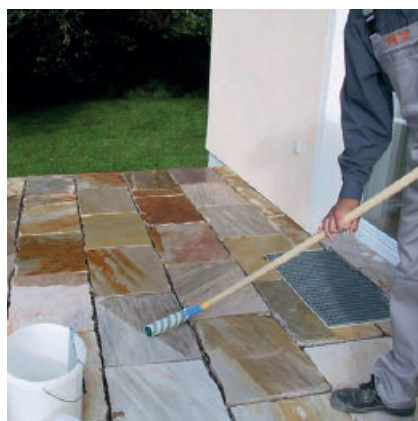
... anschließend PCI Pavifix V deckend auf die Steinoberfläche auftragen.
