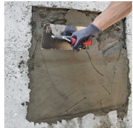
Der schnelle Reparaturmörtel PCI Nanocret R4 Rapid ist sofort modellierbar und trocknet auch bei Temperaturen ab 1 °C aus.
