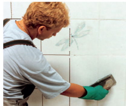
Mit PCI FT Fugengrau und PCI FT Fugenweiß können Fugen von 2 bis 8 mm Fugenbreite rissfrei verfugt werden.
