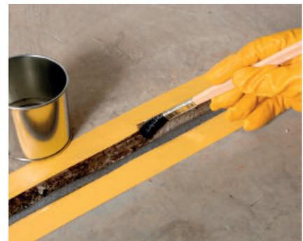
PCI Elastoprimer verbessert die Haftung von PCI-Fugendichtstoffen auf den angegebenen Untergründen (siehe PCI-Primer-Tabelle S. 4 und 5).
