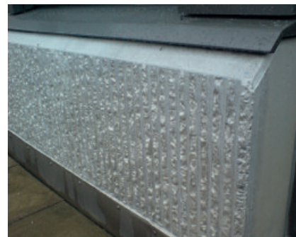
Leicht pigmentierter Oberflächenschutz durch PCI Betonfinish Lasur.
