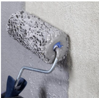
Aufbringen einer Kontaktschicht mit dem Roller.
