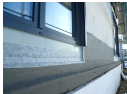
Anschluss eines bodentiefen Fensters im Übergang zur Sockelabdichtung mit PCI Barraseal Turbo.
