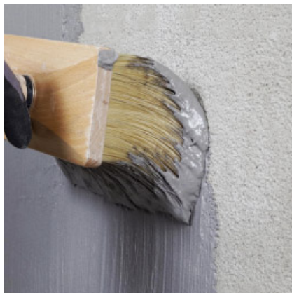
Aufbringen einer Kontaktschicht mittels Bürste oder Quast.
