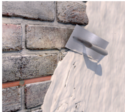
5. Überarbeiten des Mauerwerks mit PCI Saniment 2 in 1
