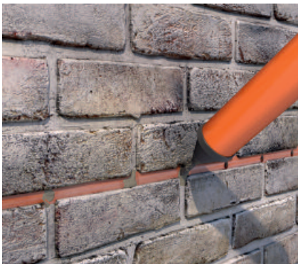
4. Verschließen der Bohrlöcher mit der Zementsuspension PCI Barra Inject
