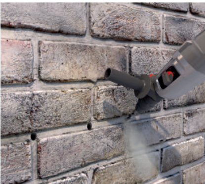
1. Bohren und anschließend Bohrloch ausblasen.
