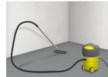
1 Tragfähigen, geeigneten Untergrund reinigen
