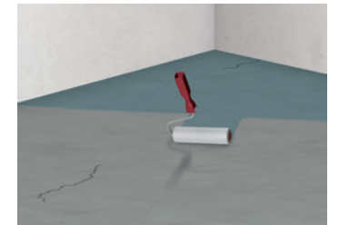
2 Grundieren des Untergrundes, z.B. mit ASO-Unigrund
