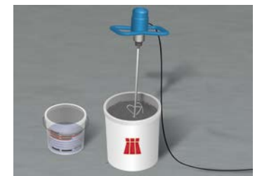
6 Anmischen der Ausgleichsmasse
