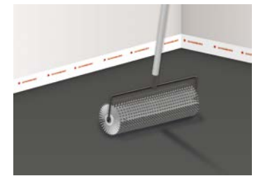
8 Egalisieren und Entlüften der frischen Ausgleichsmasse
