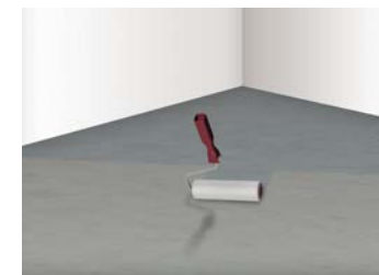
3 Grundieren des Untergrundes, z. B. mit ASO-Unigrund
