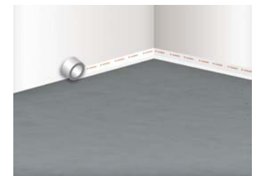
4 Stellen eines Randdämmstreifens mit RD-SK50
