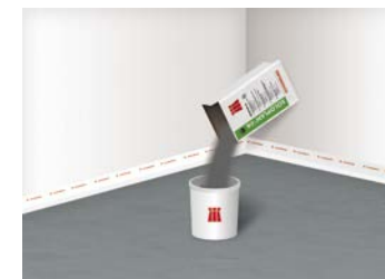
5 Einfüllen der Ausgleichsmasse in abgemessene Wasservorlage
