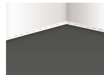
9 Fertige, begehbare Ausgleichsmasse
