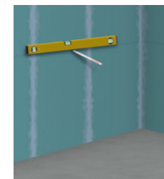
5 Einteilen der Wandfläche
