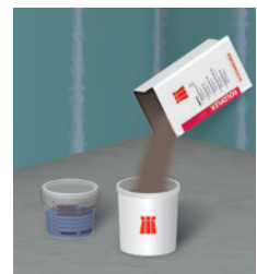
3 Einfüllen des Klebemörtels in Maßeimer
