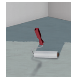
8 Grundieren des Untergrundes, z.B. mit ASO-Unigrund
