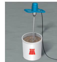
4 Anmischen des Klebemörtels
