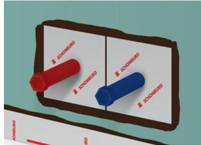
**2.** Flächiges Auftragen der SCHOMBURG Verbundabdichtung im Bereich der Baustopfen, ca. 2 cm größer als die zu verwendende ASO-Dichtmanschette-W. ASO-Dichtmanschette-W mit der flexiblen, gummierten Dichtlippe über die ASO-DMH stülpen und sorgfältig und faltenfrei in den ersten Auftrag der SCHOMBURG Verbundabdichtung einarbeiten.
