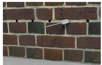
3. Bohrlöcher reinigen
