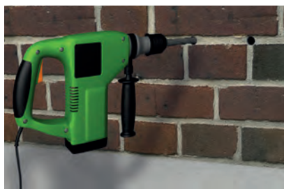
2. Bohrlöcher erstellen
