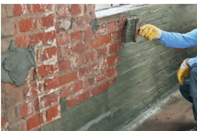
1. Vorbereitung des Boden-/Wandanschlusses
