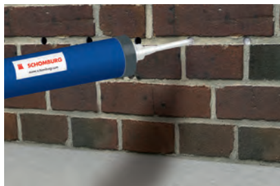
5. Horizontalsperre herstellen (pastös)
