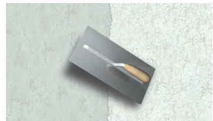
2. Sanierputz auftragen
