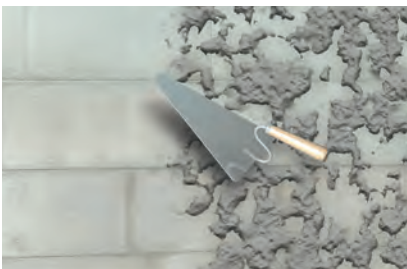
Spritzbewurf/Haftbrücke
