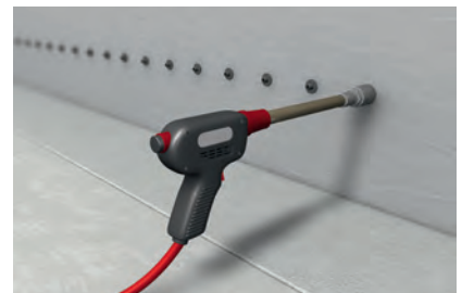
5. Horizontalsperre herstellen (wässrig)
