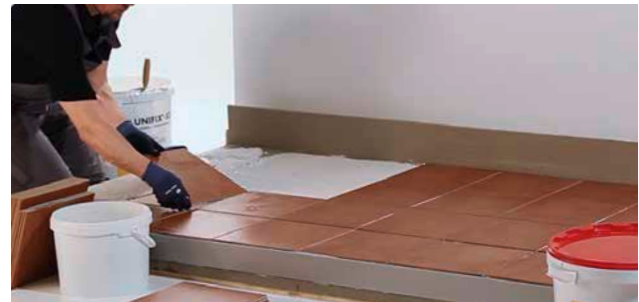
Einschieben der Fliesen in das Fliesenkleberbett, hier im kombinierten Buttering- & Floating-Verfahren.
