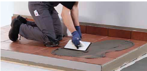
Einfügen des Belages mit ASO-Flexfuge.
