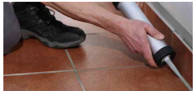
Elastische Fugen mit geeigneter geschlossenzelliger Rundschnur und ESCOSIL-2000-ST versiegeln.
