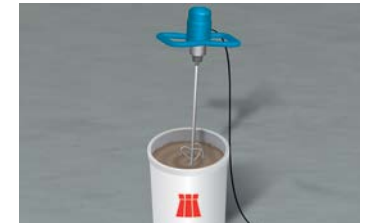
4 Anmischen des Klebemörtels
