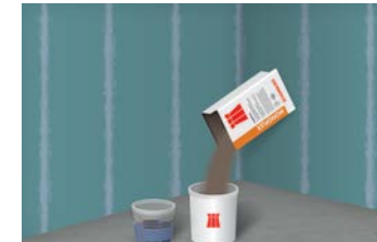
3 Einfüllen des Klebemörtels in einen sauberen Mischeimer
