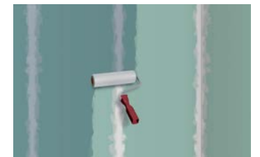
2 Grundieren des Untergrundes, z.B. mit ASO-Unigrund
