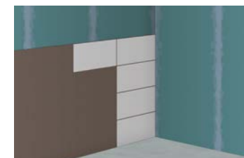
7 Verlegen der Wandkeramik
