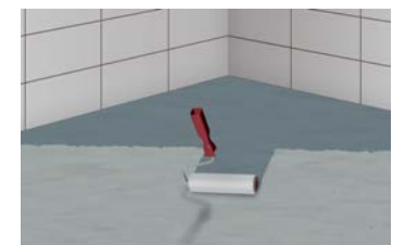
8 Grundieren des Untergrundes, z.B. mit ASO-Unigrund
