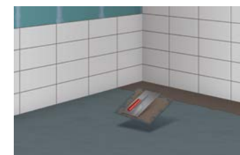
11 Auftragen einer Kontaktschicht bei größeren Formaten
