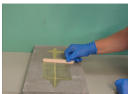
Abziehen des Überschussmaterials
