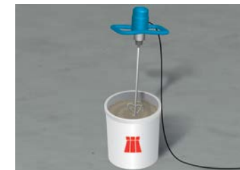
4 Anmischen des Fugenmörtels
