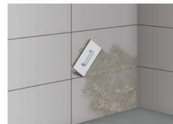
5 Einbringen des Fugenmörtels
