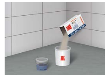
3 Einfüllen des Fugenmörtels in einen sauberen Mischeimer
