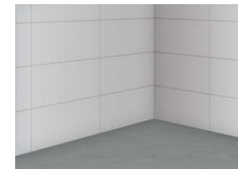
10 Fertig verfugte Wandfläche
