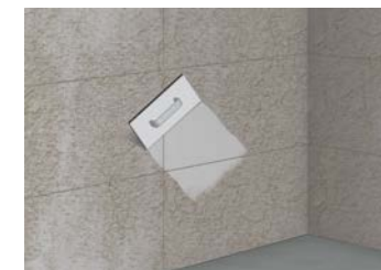
6 Diagonales Abschieben überschüssigen Fugenmörtels
