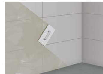
9 Nachwaschen der Fläche diagonal zur Fugenrichtung
