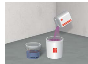
8 Verdünnen von ASO-Unigrund-S mit Wasser 1:1
