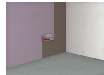
10 Aufkämmen z. B. eines Klebemörtels
