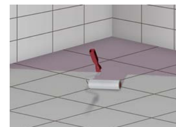
4 Gleichmäßiges verteilen von ASO-Unigrund-S mit einer Lammfellrolle
