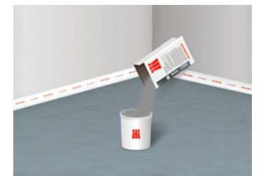
2 Einfüllen des Estrichmörtels in einen sauberen Mischeimer
