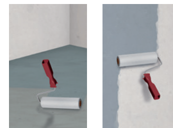
3 Grundieren des Untergrundes, z. B. mit ASO-Unigrund
