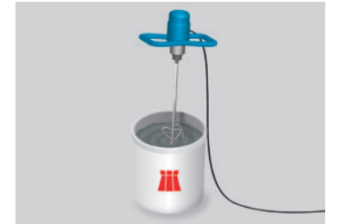
4 Anmischen der Abdichtung
