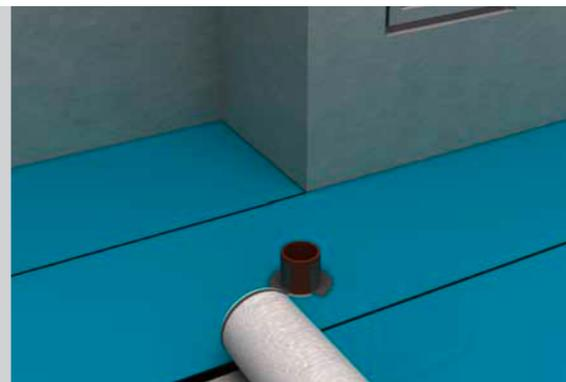
3. Die Verklebung möglichst faltenfrei durchführen. Der schwarze Randstreifen an der Rollenseite der Gefitas 3/300 dient zur Orientierung für eine ordentliche Verklebung.
