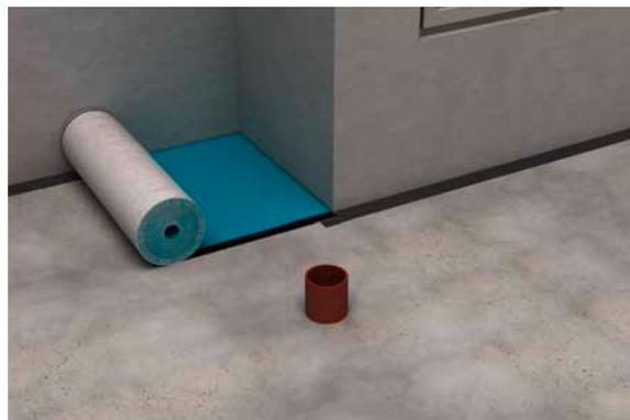
1. Die Gefitas Feuchtigkeitssperre auf dem gereinigten Boden ausrollen, an die Mauersperrbahn heranführen und überlappend verlegen.
