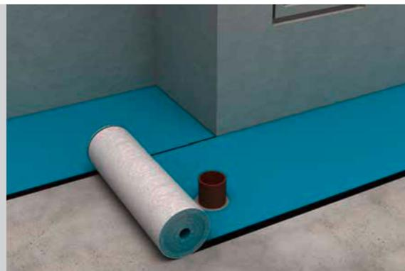
2. Die Anschlussbahn mit der ersten Bahn überlappend verlegen. Die Überlappung sollte mindestens 5cm betragen. Anschließend die Schutzfolie von dem längsseitigen Klebestreifen der Bahn mittig beginnend abziehen und mit der darunter liegenden Bahn verkleben.
