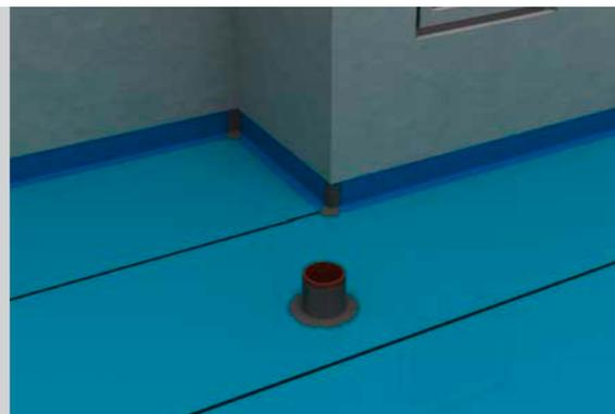
6. Den Fuß des Gefitas Anschlussstreifens in den Ecken einschneiden und umlaufend verlegen.
