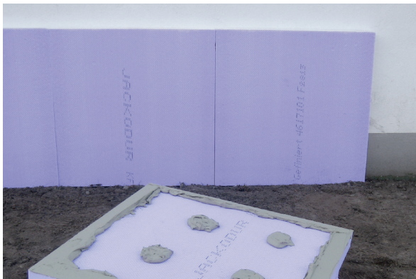
Bild 1: Sockeldämmung mit JACKODUR Gefiniert
