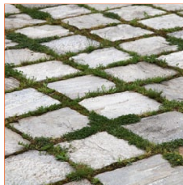
Verlegebeispiel Rasenfugenkreuze im Kreuzverband mit Pflastersteinen
