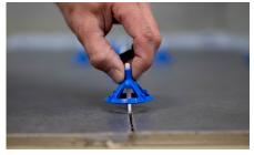
Anschließend erfolgt das Aufsetzen der Spincaps. Durch das Grobgewinde kann die Kappe schnell auf Position gedreht und festgezogen werden.
