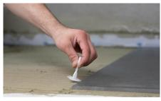
Die erste Fliese wird in das frische Mörtelbett eingelegt. Anschließend werden die konisch geformten Gewindelaschen unter die Fliesenkante geschoben. Die Anzahl ist dem Fliesenformat nach der Tabelle (siehe Gebinde) zu entnehmen.
