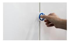
Das Drehen erfolgt nicht auf der Fliesenoberfläche sondern auf der Unterlegplatte aus Kunststoff. Nach Aushärtung des Klebemörtels die Spincap und Gewindelasche abschlagen (siehe Bild 6).
