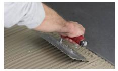
Auf den vorbereiteten Untergrund wird der Dünnbettörtel mit der auf die Fliese abgestimmten Zahntraufel aufgekämmt. Auf der Fliesen-/Plattenrückseite ist eine Kontaktschicht und gegebenenfalls eine Zahnung aufzubringen.
