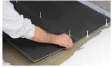
Die nächste Fliese wird bis an die Gewindelaschen angelegt und unter Druck in das Mörtelbett eingelegt. Die Gewindelaschen geben gleichzeitig die Fugenbreite vor. Breitere Fugen sind möglich.
