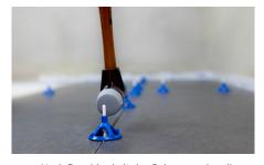
Nach Begehbarkeit des Belags werden die Spincap und Gewindelasche durch Abschlagen an der Sollbruchstelle getrennt. Das Abschlagen erfolgt in Längsrichtung der Fuge. Die Spincaps sind zur mehrfachen Nutzung geeignet.
