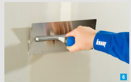
Überspachteln des Fugendeckstreifens
