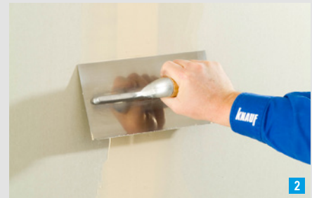
Abziehen in Längsrichtung
