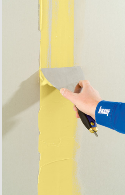
Gelb eingefärbte Knauf Safeboard-Spachtel
