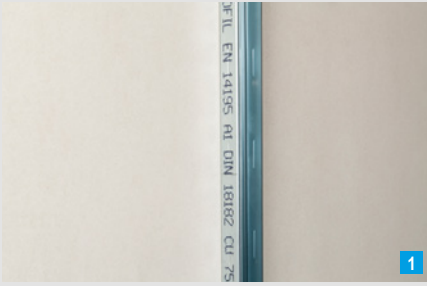
Profil auf angrenzendes Bauteil montieren
