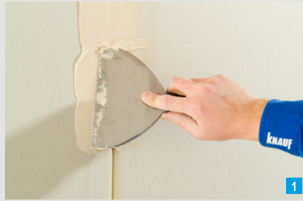
Eindrücken der Spachtelmasse quer zur Fuge
