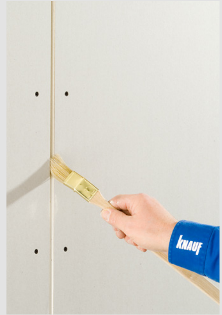
Auftragen von Knauf Tiefengrund auf angefasste Schnittkanten
