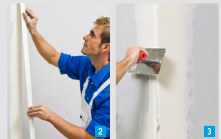
... und einlegen, anschließend überspachteln
