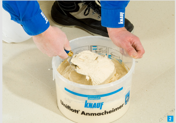
Anrühren von Knauf Uniflott mit der Kelle
