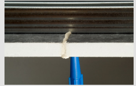
Seitenansicht beim Füllen der Fuge mit Knauf Uniflott
