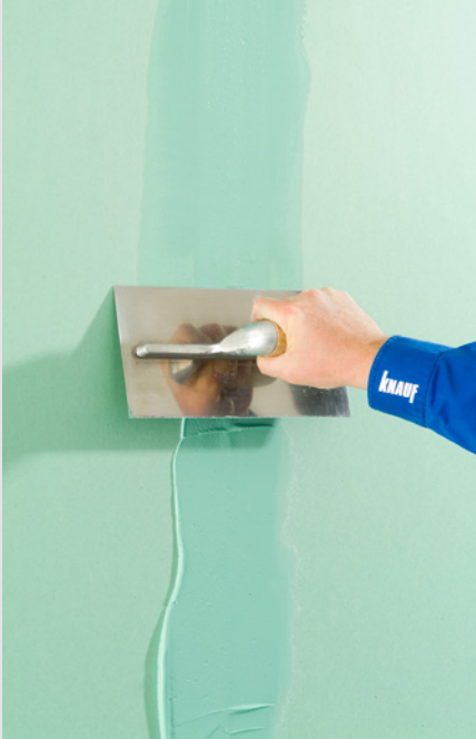
Knauf Uniflott imprägniert für imprägnierte (grüne) Gipsplatten
