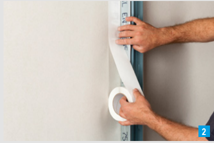
Trenn-Fix neben Profil kleben
