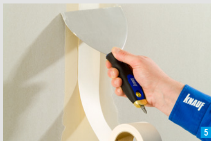
Einlegen des Fugendeckstreifens
