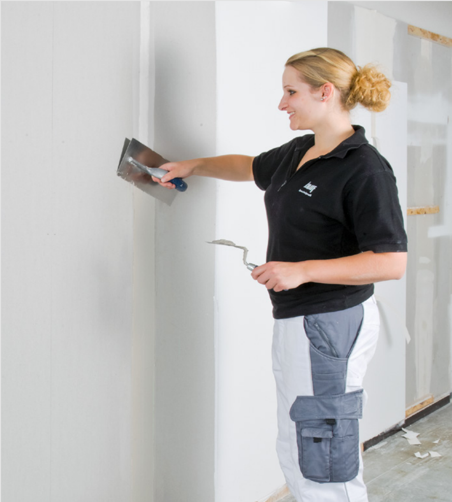
Rissicher spachteln mit Knauf Spachteln und Fugendeckstreifen
