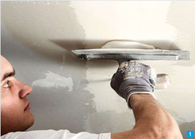
Der manuelle Spachtelauftrag kann nicht nur mit der Glättkelle, sondern auch mit einer langflorigen Lammfellrolle erfolgen.
