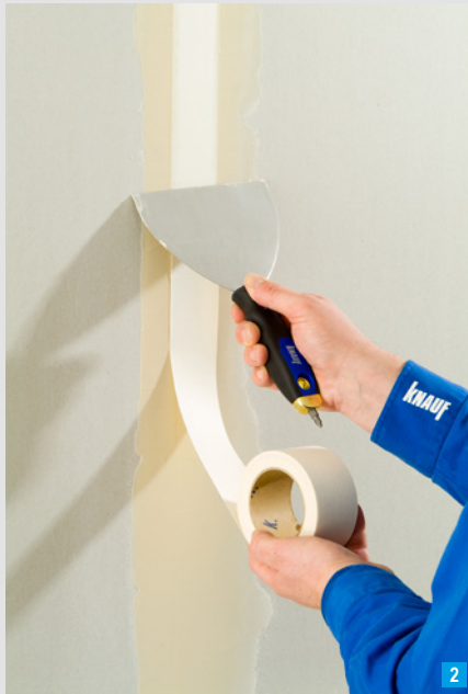
Einlegen des Fugendeckstreifens
