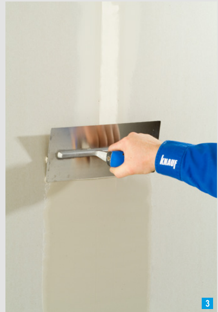
Überspachteln des Fugendeckstreifens mit gebogener Traufel
