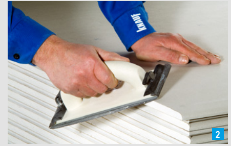
Brechen mit dem Handschleifer bei Knauf Cleaneo-Platten
