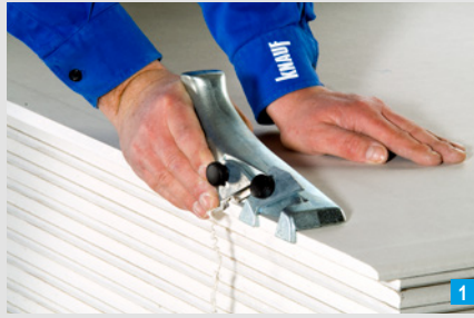
Anfasen einer SFK mit dem Kantenhobel
