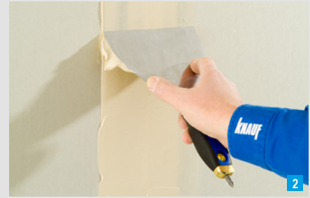
Abziehen in Längsrichtung
