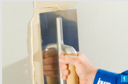
Eindrücken der Spachtelmasse quer zur Fuge
