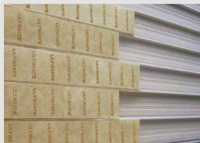
Mineralwolle-Filze überdecken die Stege und reduzieren Schallbrücken
