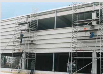
Leere Stahlkassetten vor der Dämmstoff-Verlegung
