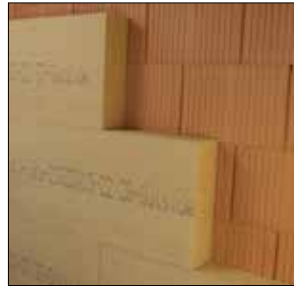
Verlegung kleinformatischer stumpfer Platten
