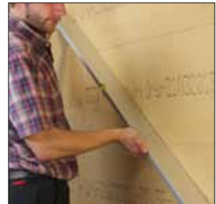
Kontrolle der Oberfläche
