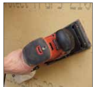
Plattenversätze beischleifen
