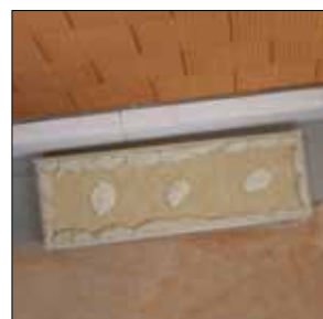
Dämmplatte ankleben auf unebenem Untergrund im Punkt-Wulst-Verfahren
