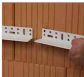
Winkelschiene anbringen
