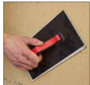
Plattenversätze beischleifen
