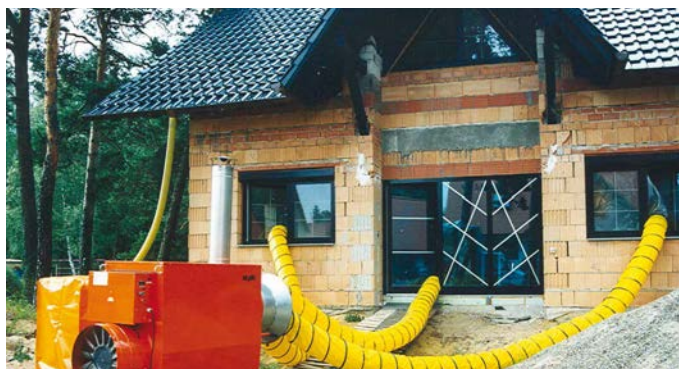
Beheizung in der Bauphase
