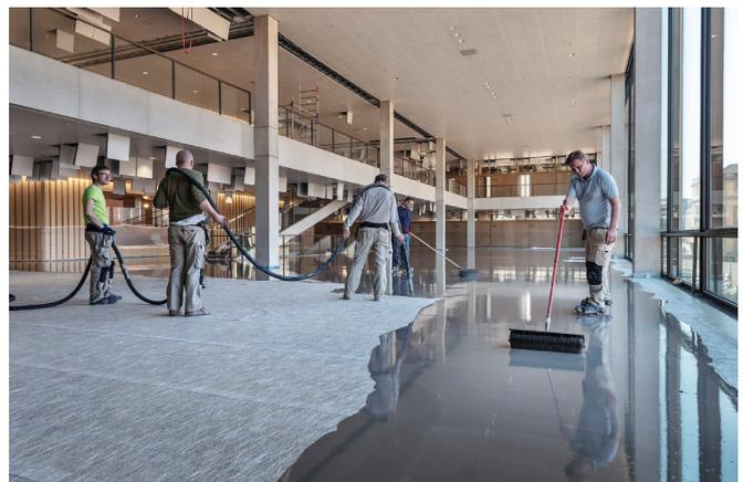
Überspachteln mit Hilfe von Pumptechnik von UZIN RR 201 mit UZIN NC 170 LevelStar.
