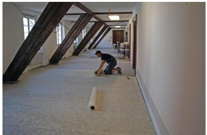
Flächiges Auslegen von UZIN RR 201 auf den zu sanierenden Untergrund.
