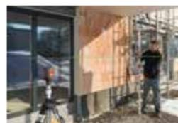
Im Außenbereich bietet der HORIZON GREEN eine kostengünstige Alternative zum Rotationslaser: Gerade auf kleineren Baustellen lassen sich mithilfe von Stativ und Messlatte Höhendifferenzen schnell und problemlos überprüfen. Dank Schutzklasse IP54 ist das robuste Gehäuse des Lasers vor Spritzwasser und Staub geschützt.
